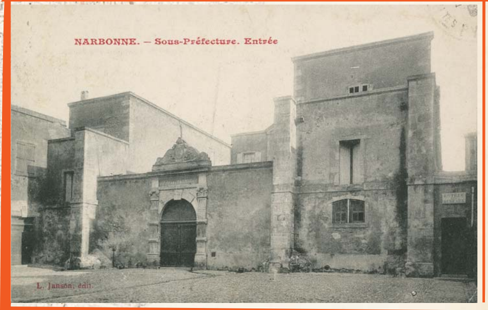
La sous-préfecture de Narbonne (A. D. Aude, 2Fi5747)
