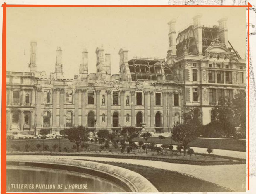
Le Palais des Tuileries incendié le 23 mai 1871 (A. D. Aude, 2Fi6243/3)
